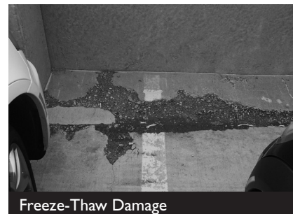
Spalling
